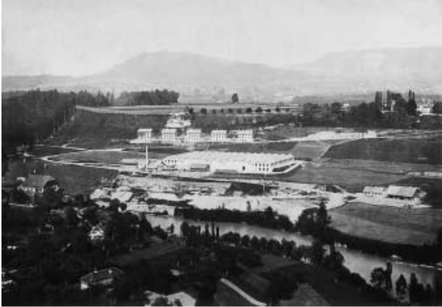
Abb. 1 Die Spinnerei Felsenau von Westen um 1867. Im Mittelpunkt steht die zwei-stöckige Fabrik im Zustand vor dem Brand von 1872. Oberhalb von ihr befinden sich fünf der insgesamt neun Einfamilienhäuser mit Arbeiterwohnungen. Unterhalb der Fabrik ist das Aushubmaterial des Kraftwerksstollens deponiert. Darauf wurden 1871/72 die Einfamilienhäuser der Siedlung untere Felsenau errichtet. Am rechten Bildrand sieht man den Bauernhof, der das Land rund um die Fabrik bewirtschaftete.
