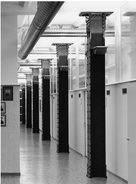
... über die genieteten Walzprofilstützen des Erweiterungsbau von 1907 (Blick in das Erdgeschoss, Historisches Institut)...
