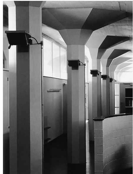
... zu den Eisenbeton-Pilzstützen der neuen Fabrik am Lerchenweg von 1957.
