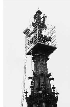
Berner Münster: Die Turmspitze während der Sicherungsarbeiten.
