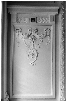
Bollwerk 27: Detail des Wandstücks im Grossen Saal; ebenso nebenstehendes Bild.
