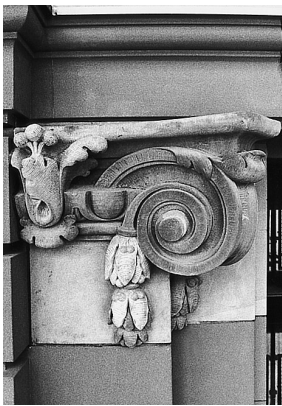
Bollwerk 25: Details von zwei Fassadenplastiken.
