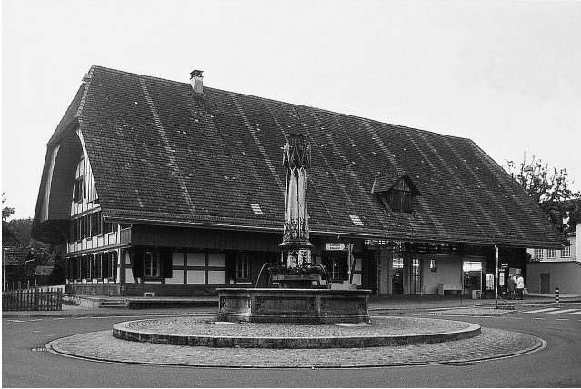
Bernstrasse 75–79: Das mächtige Bauernhaus nach dem Umbau.
