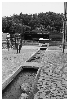
Mattebach: Der als Spielbach wiederhergestellte Bach im Bereich zwischen den Schulhäusern.
