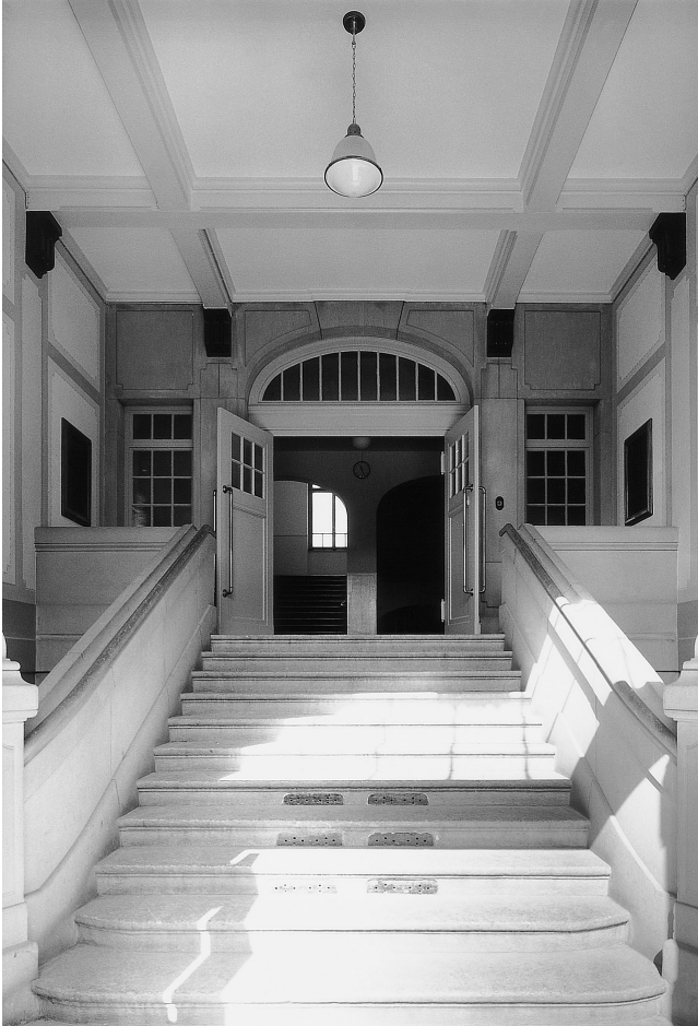
Bitziusstrasse 15: Die restaurierte, ursprünglich offene Eingangshalle.
