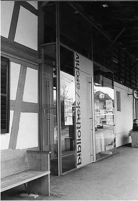
Bernstrasse 75–79: Neue Eingangspartie anstelle des alten Tenntors.
