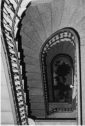
Aegertenstrasse 1: Das vom Lifteinbau im Treppenauge verschonte, schwungvolle Treppenhaus.
