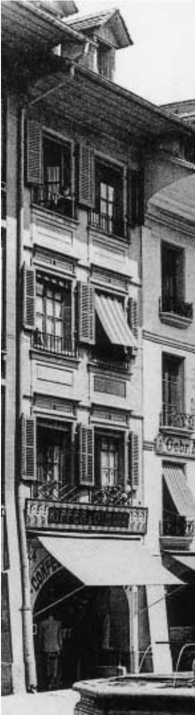
Abb. 3 Die Amtswohnung Wyttenbachs war das damals dreistöckige Haus Spitalgasse 24, das dieses zwischen 1890 und 1910 entstandene Foto zeigt. Die Fassade der Liegenschaft existiert auch heute noch, allerdings ist sie seit 1954/55 um eine Etage aufgestockt, und das Hausinnere ist verändert.
