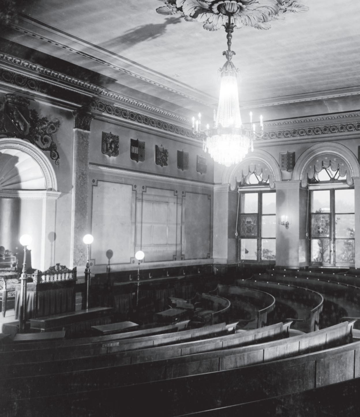
Umbau Rathaus 1940–1942: Blick in den 1832–1834 eingebauten Saal des Grossen Rates kurz vor dem Abbruch: Die Bänke der Grossräte sind im Halbkreis um den Präsidentenstuhl an der Westmauer des Rathauses angeordnet, die Fenster liegen wie heute an der Nordseite. – StAB, BB 05.7.846, Nr. 95. Foto: Hans Steiner, Dezember 1940.
